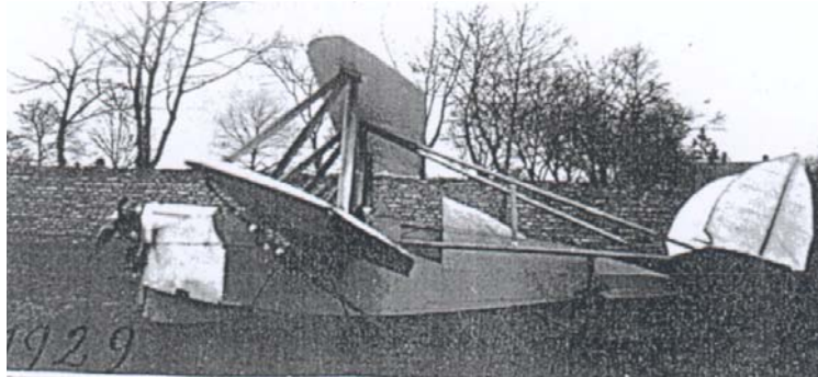
1932 L'hélica I triplace, réalisée chez Lioré et Olivier fait des essais, Leyat dit dans l'interview qu'on lui a imposé une incidence fixe pour les essais, après un décrochage au raz du sol et un cheval de bois, Lioré et Olivier renonce à cet avion.
